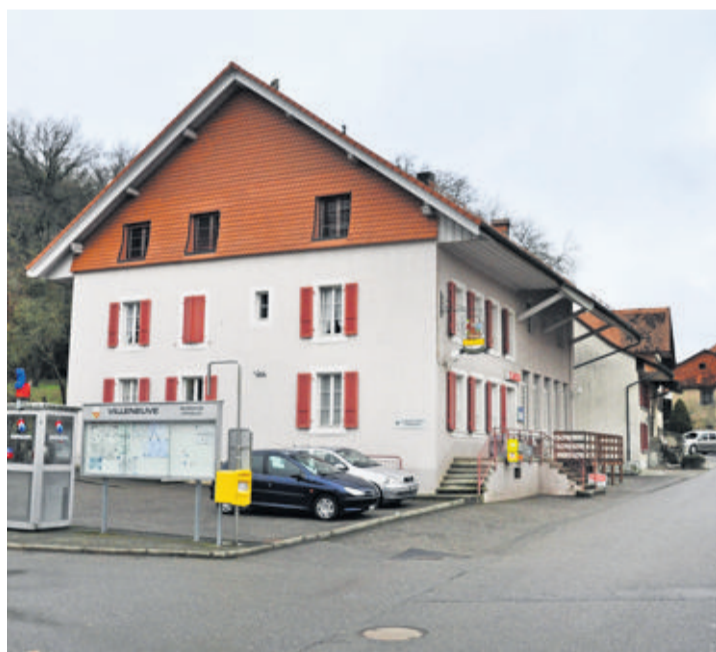
Le bâtiment de l'auberge et de l'administration communale va subir des travaux de mise aux normes.
