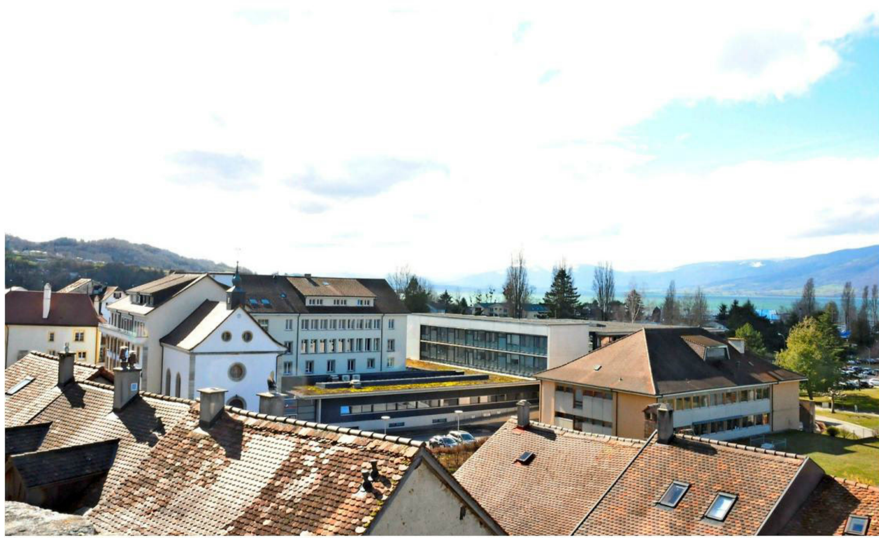
Un volume de plus de 75 000 m 3 de locaux sera raccordé à ce nouveau système, dont la mise en fonction est prévue pour 2020. PHOTO ISABELLE KOTTELAT
