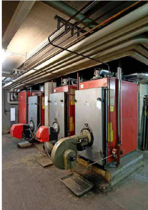
L'actuel chauffage à mazout du site staviacois de l'Hôpital intercantonal de la Broye (HIB) sera remplacé par deux nouvelles pompes à chaleur. Charly Rappo
